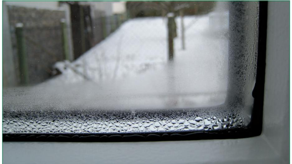
Abb. 3: Durch den Aluminium-Abstandhalter im Isolierglas kann am Rand der Glasscheibe leicht Tauwasser entstehen.
